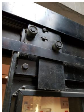
Serrure de porte palière du niveau principal
